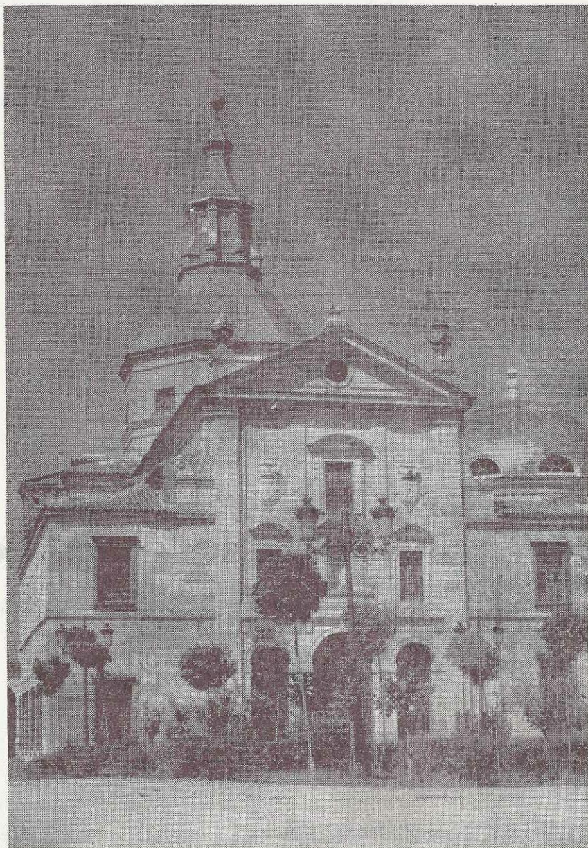
Convento Dominicos. Fachada Principal
